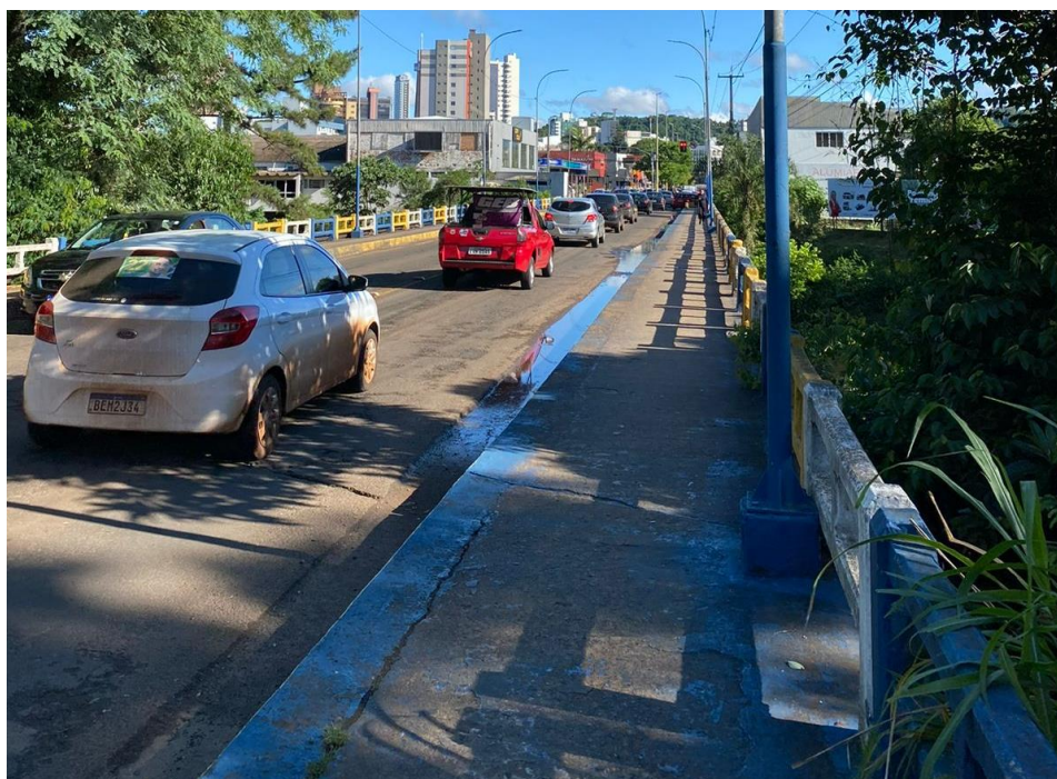
Figura 29 - Ponte Júlio Assis
