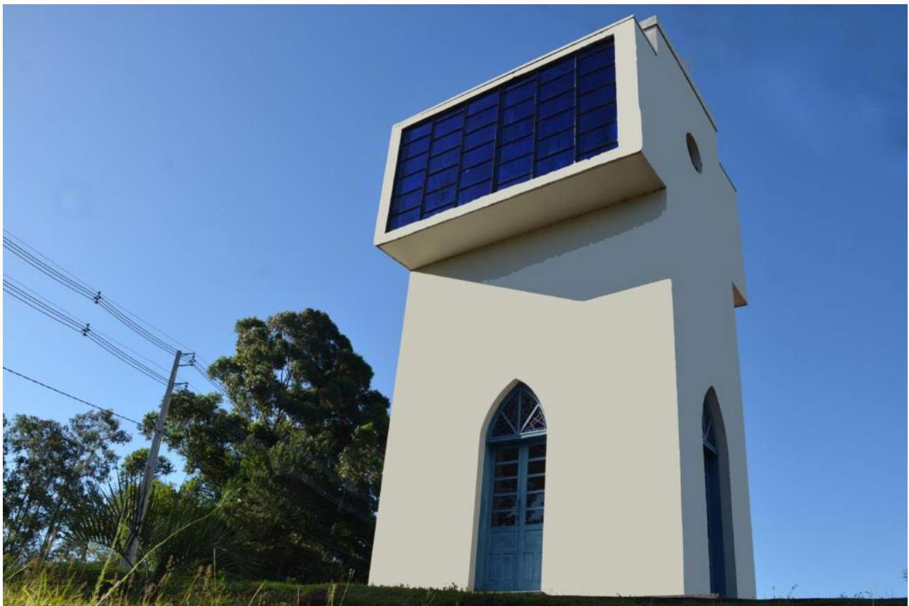
Figura 35 - Fachadas da Capela São Cristóvão
